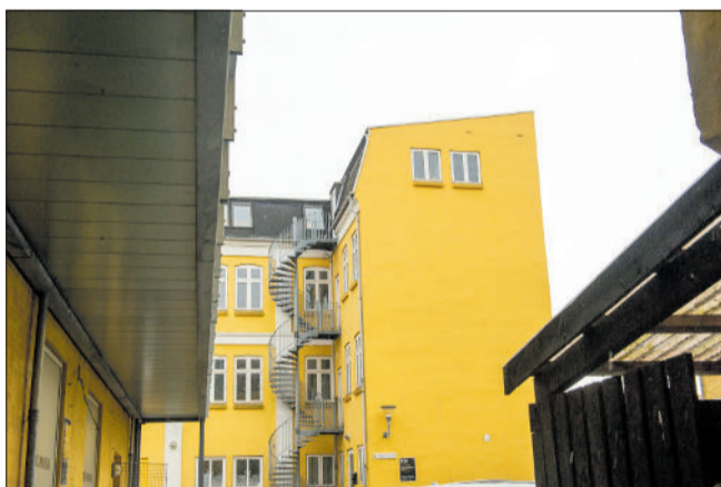
Ejendommen i Langes Gaard, som i øjeblikket er under ombygning.
